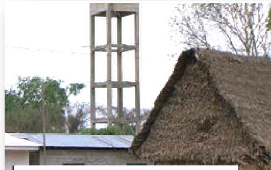
Tanque de agua elevado en Contravaria
